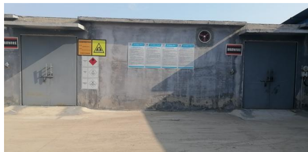
危废暂存间外部
