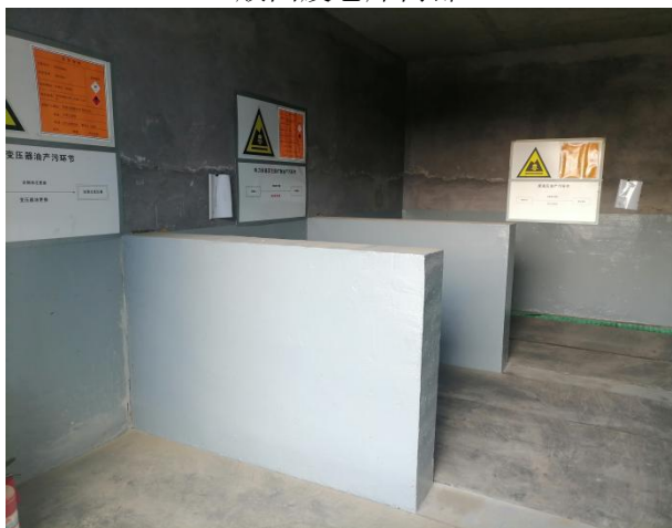
危废暂存间内部
